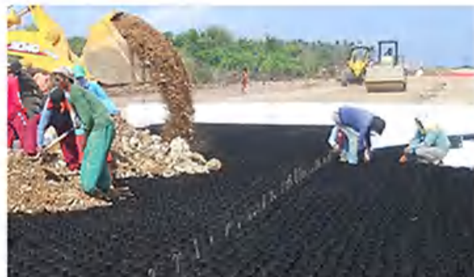
Garbage Landfill Geocell
