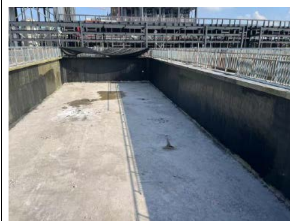
污水处理站防渗措施施工照片
