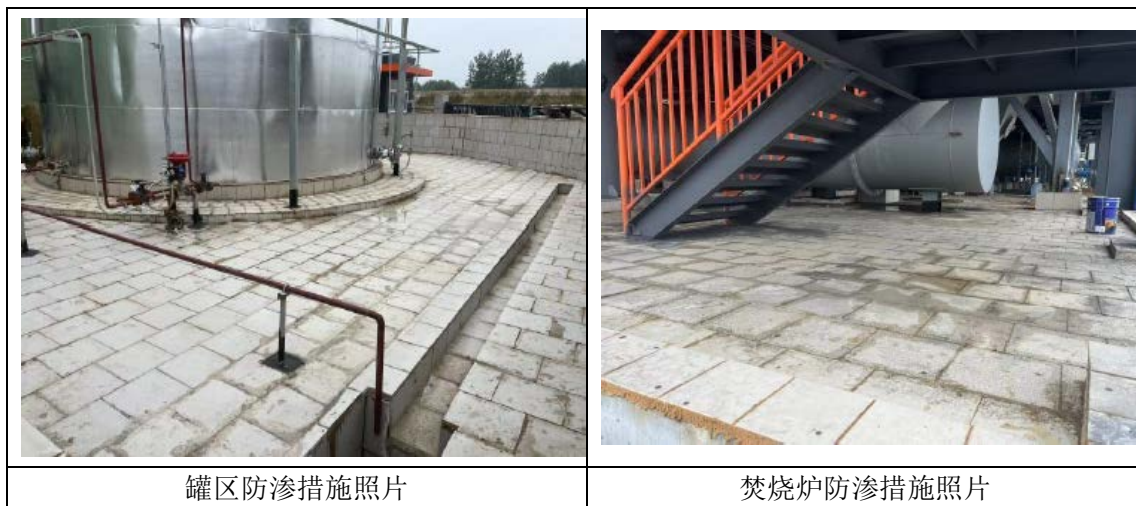
图 4.2-1 防渗措施建设情况照片
