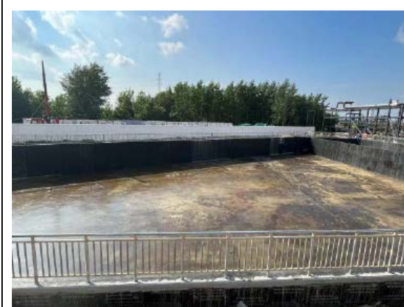
事故应急池防渗措施施工照片
