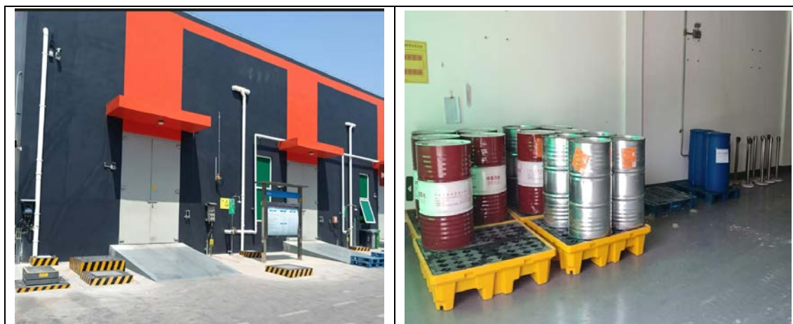
图 4.1-9 项目危废暂存间
