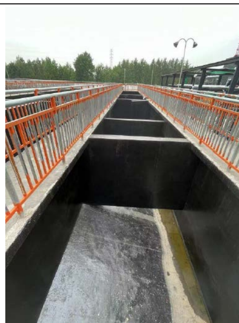
污水处理站防渗措施施工照片
