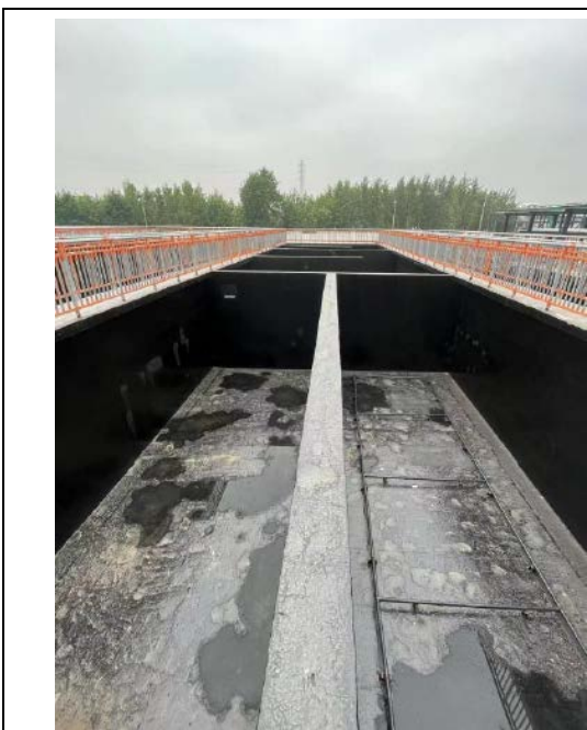
污水处理站防渗措施施工照片
