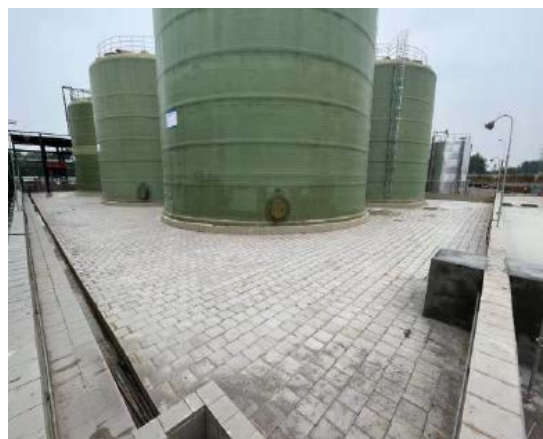
罐区防渗措施照片
