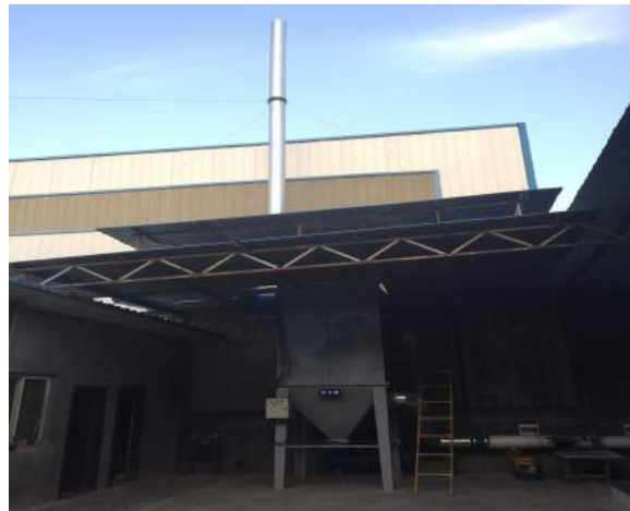
项目打磨工序布袋除尘器及排气筒
