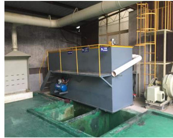
项目酸碱废水一体化处理设施及沉淀池
