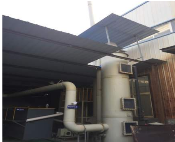
项目酸雾净化塔及排气筒
