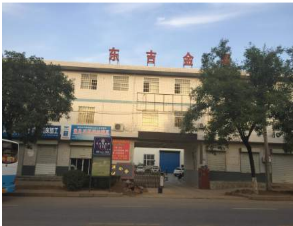
项目厂区大门
