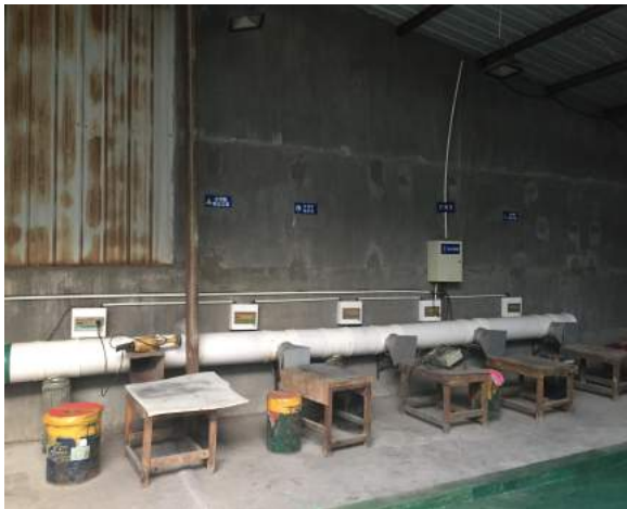
项目打磨工序集气罩及管道
