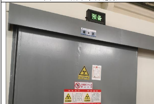
图 6-3 探伤室工作警示灯、辐射警告标志
