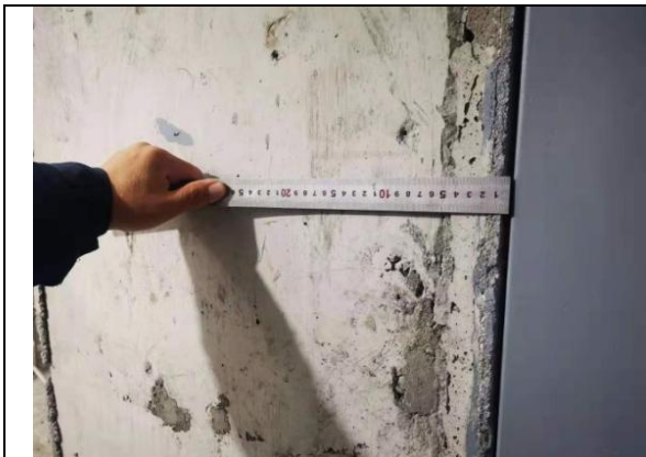
图 6-1 铅门与墙缝隙
