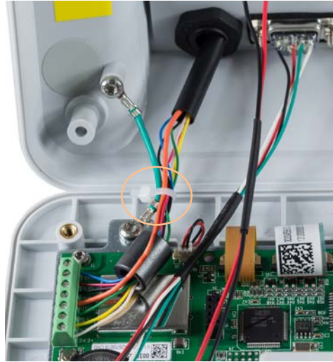
Figure 2-20 : Broche de masse du capteur analogique et installation de la ferrite, IND231
