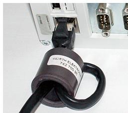
Abb. 43 Ethernet-Leitung, Schlaufe 2-fach durch Ferrit
