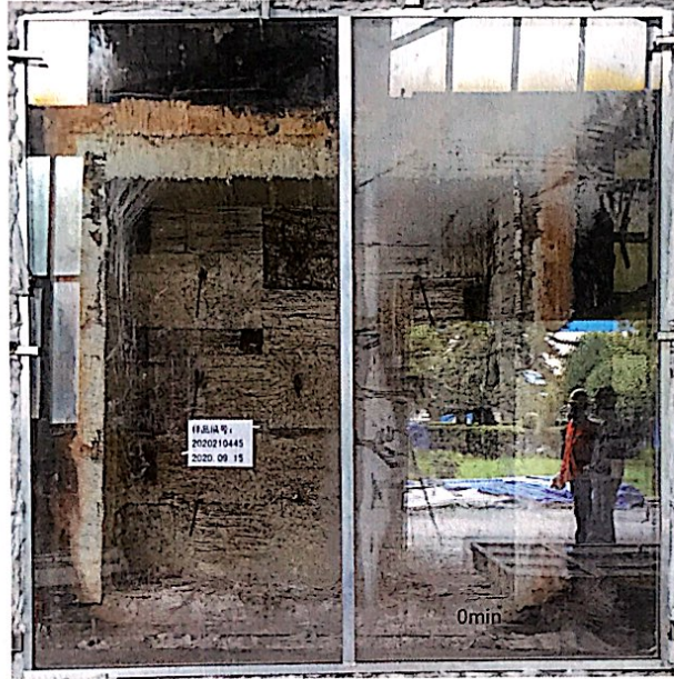
照片 1 耐火性能试验前试件情况
