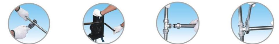
使用切管工具将管材裁切至适合安装的长度。切管工具根据需要可使用切管器或切管机。
